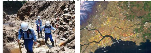
現地調査 被災状況把握
