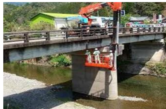
インフラの維持管理（点検作業）
