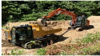
自動施工の高度化
